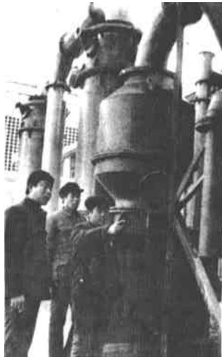
垦利县磷肥厂投资30万元，建起一套氟化氢气体回收加工装置，不仅防止了环境污染，每年还可生产出氟硅酸钠20吨，增产值8万余元。(徐兆鹏 摄)
